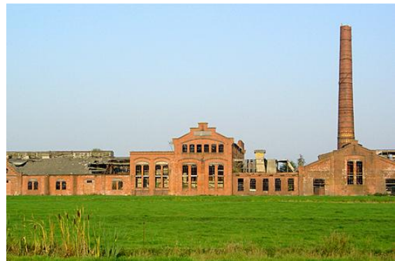
Afb. 3 Ruïne van strokartonfabriek De Toekomst, Scheemda, in 2009. (Foto: Barbara van der Linde).
